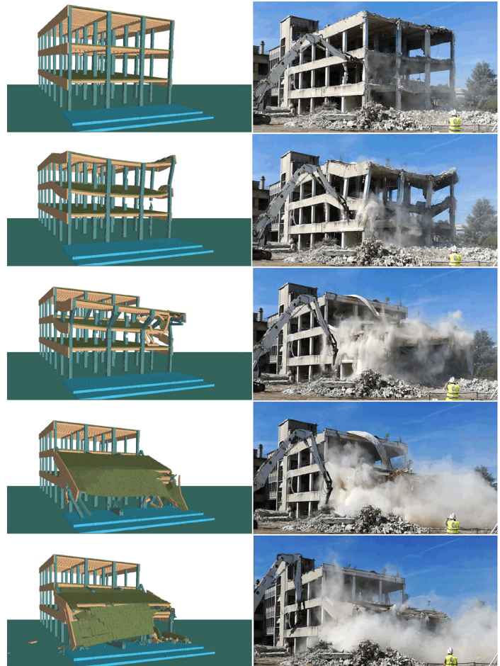
Side-by-Side Comparison of ELS Simulation and Actual Demolition
